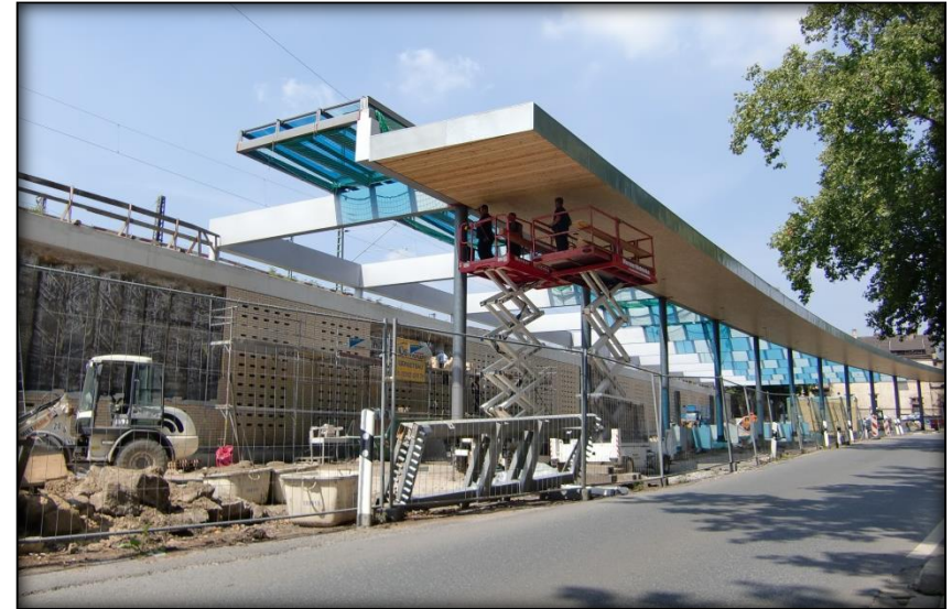
Bau der neuen Dachkonstruktion, nachher
