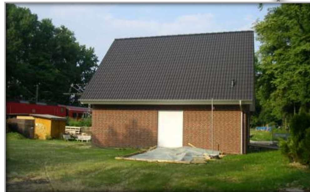
Die Bauarbeiten dieses Einfamilienhauses sind bereits beendet
