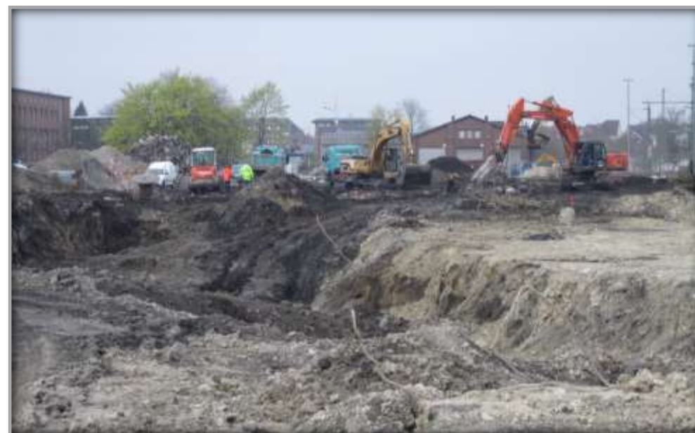
Flächenaufbereitung (Fundamente/ Altlasten)
