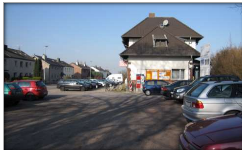
Schotterfläche am Bahnhof Millingen, vorher
