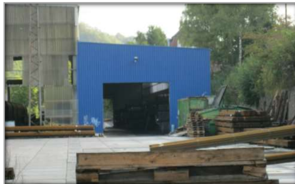
Verladehalle und Trockenlagerneubau mit Freilager im Vordergrund
