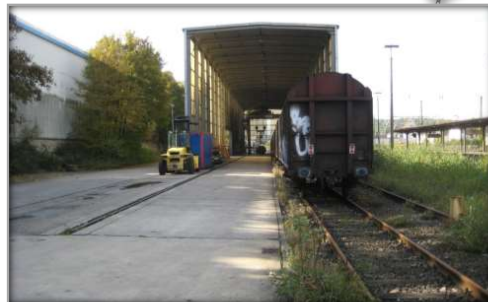
Verladeanlage nach Erneuerung der Oberflächen und Fundamente
