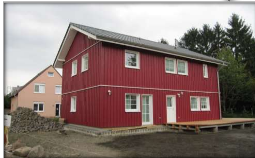
Hürth-Kalscheuren, Gronerstraße - nachher
