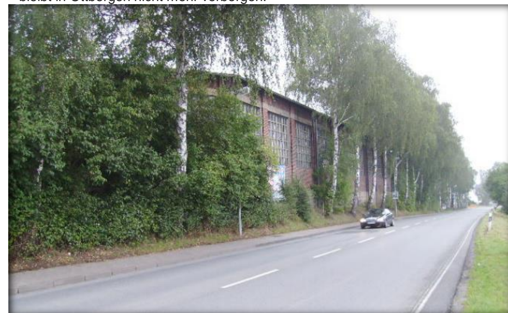
Ortsbildprägend, aber kein Hingucker – die Fassade des Ringlokschuppens an der B 64.
