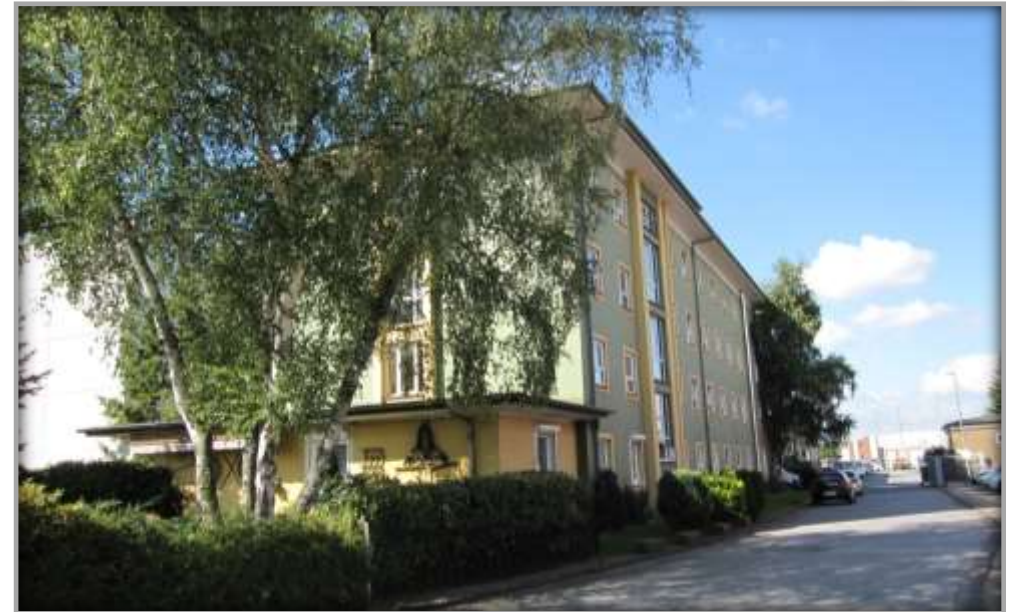
Seitenansicht von Zufahrtstraße
