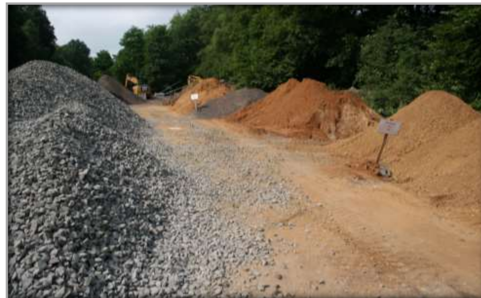
Sand- und Kieshaufen während des Streckenausbaus.
