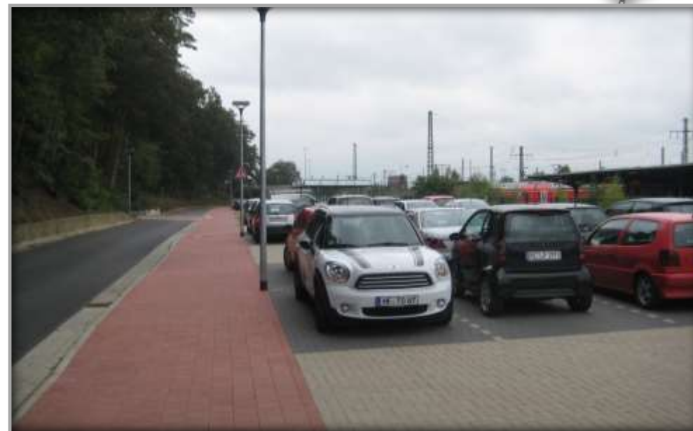
ausgebaute Park & Ride Anlage, nachher
