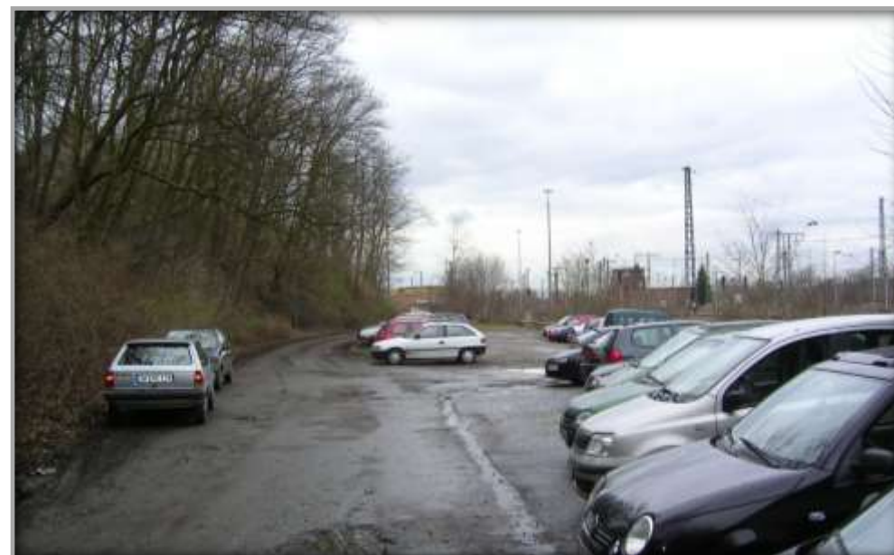
Unbefestigte Parkplatzfläche, vorher
