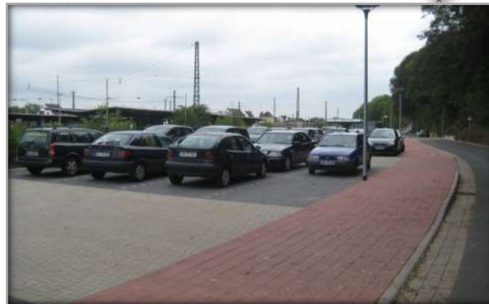
P&R Anlage nach dem Ausbau
