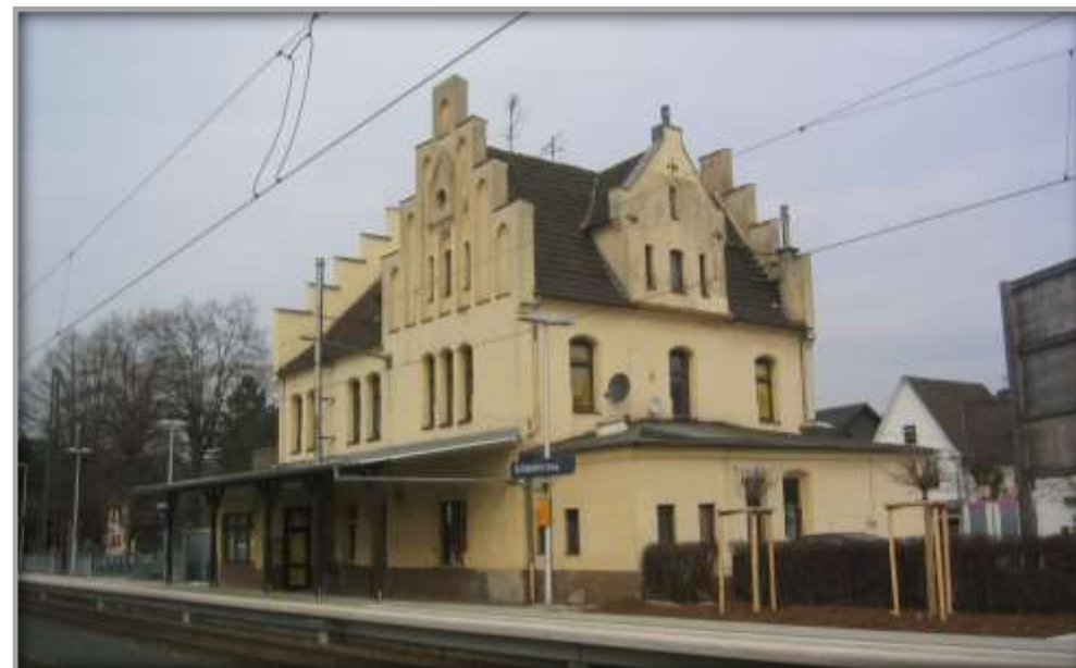
Empfangsgebäude vor Sanierung und Entwicklung
