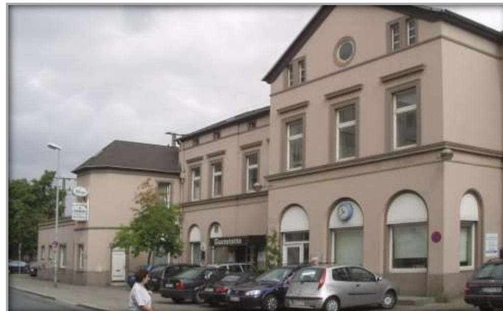
Außenansicht vor der Sanierung und Entwicklung
