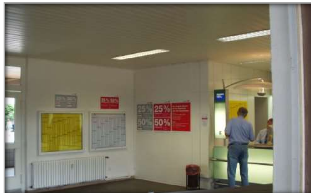
Innenbereich vor Sanierung und Entwicklung
