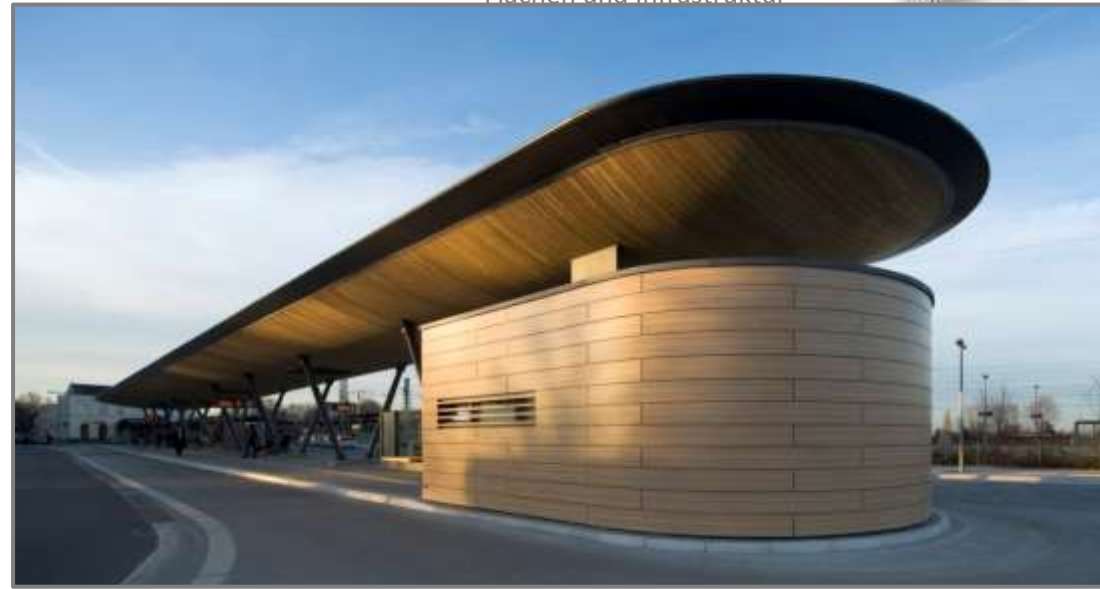
Neuer ZOB am Empfangsgebäude in Unna
