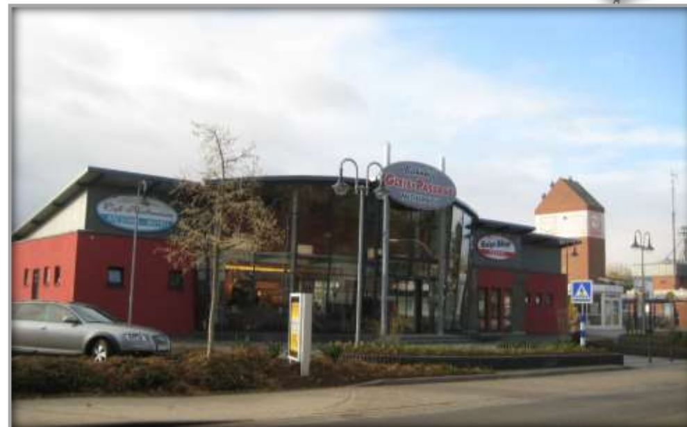
Empfangsgebäude nach der Entwicklung
