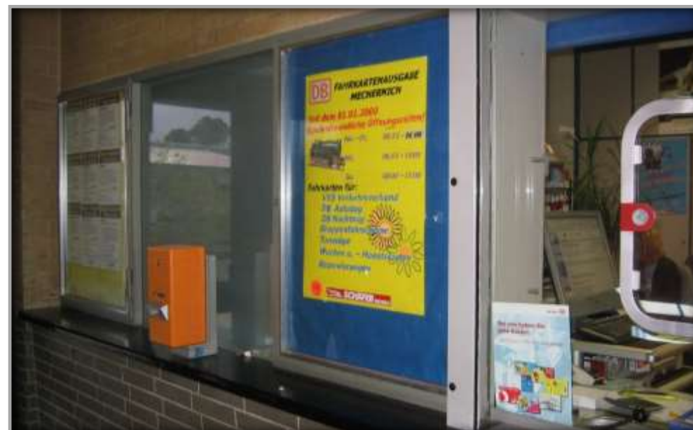
Innenbereich vor der Sanierung und Entwicklung
