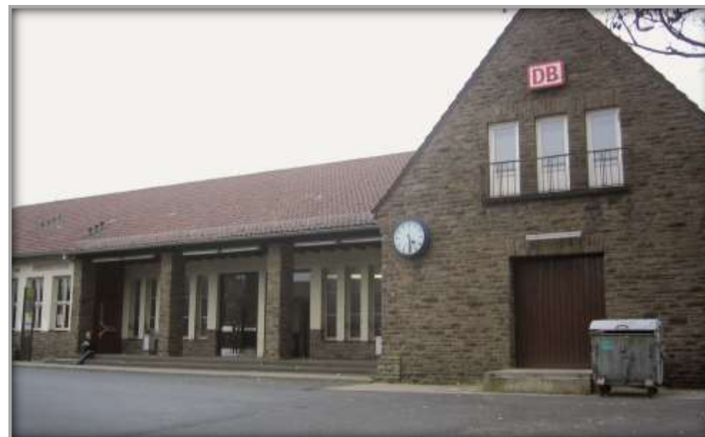
Außenansicht vor der Sanierung und Entwicklung
