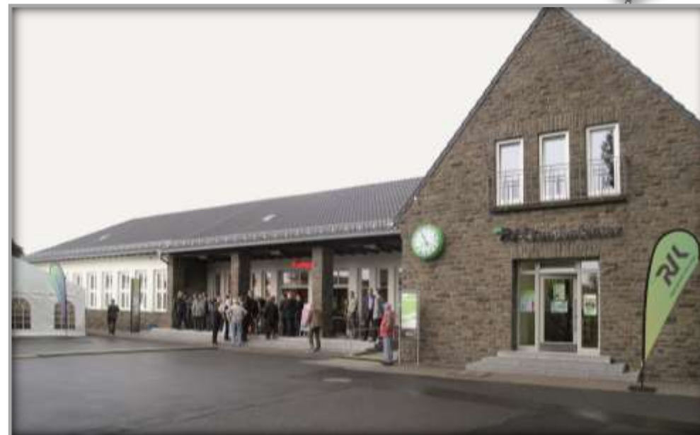
Außenansicht nach der Sanierung und Entwicklung
