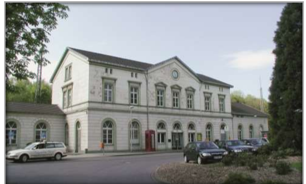
Empfangsgebäude vor Sanierung und Entwicklung
