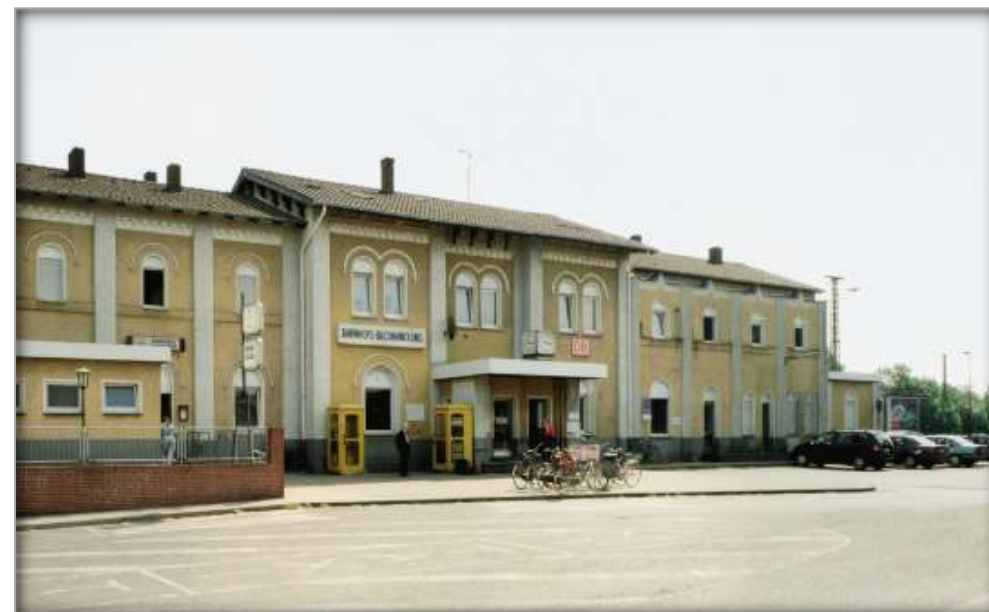
Empfangsgebäude vor Sanierung und Entwicklung
