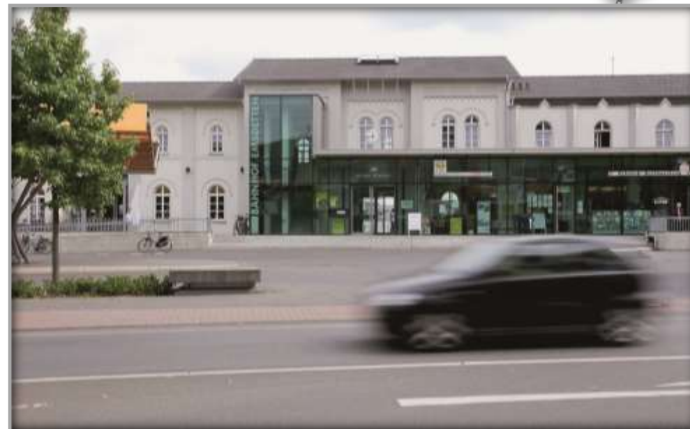
Empfangsgebäude nach Sanierung und Entwicklung
