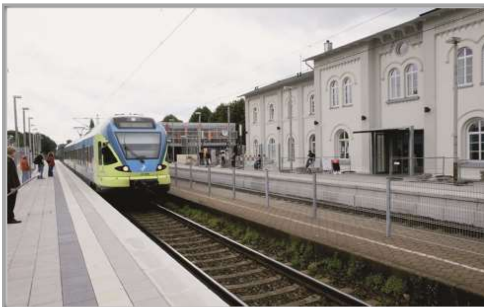
Bahnsteig nach der Sanierung
