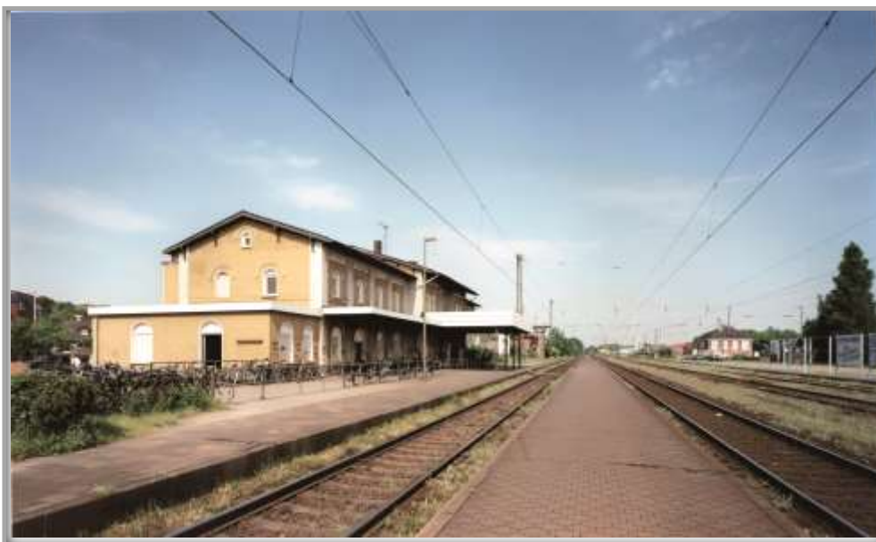
Bahnsteig vor der Sanierung
