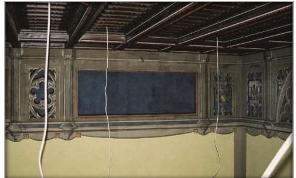
Innenbereich vor der Sanierung
