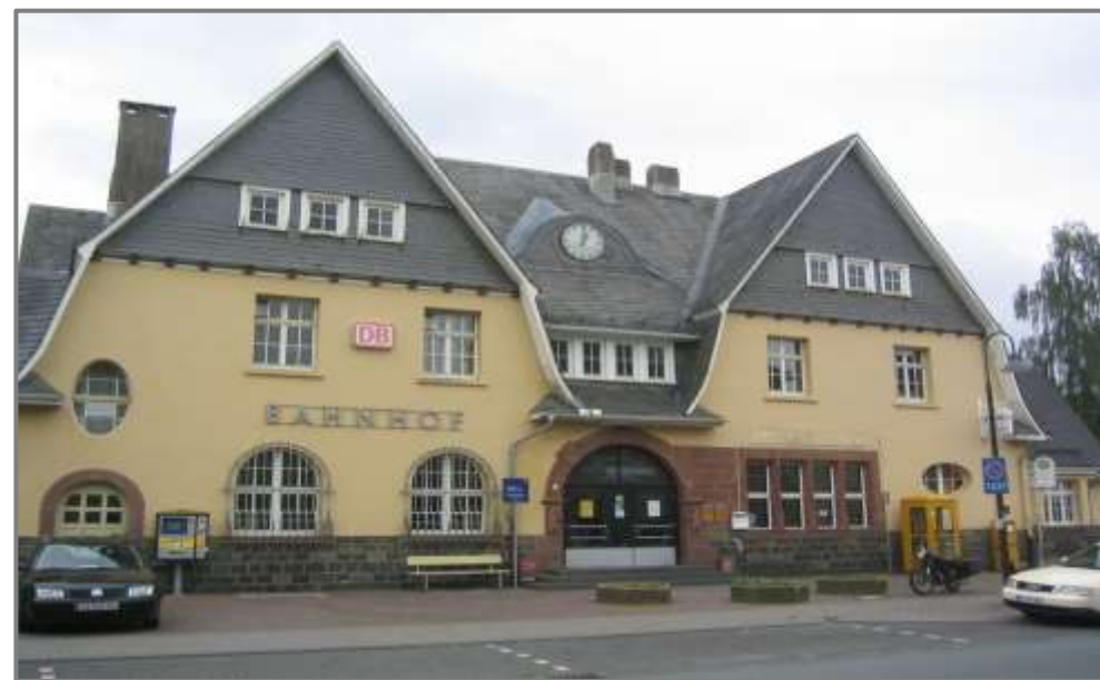
Außenansicht vor Sanierung und Entwicklung
