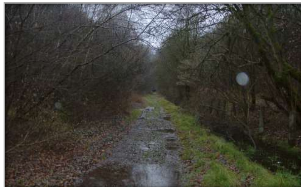
Ehemalige Trassenführung in Richtung Tunnel vor dem Ausbau
