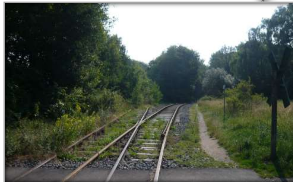
Denkmalgeschützte Trasse vor dem Ausbau zum Rad- und Wanderweg
