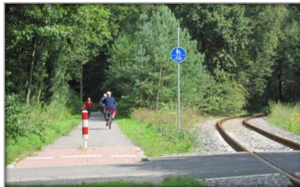
Parallel zur Trasse angelegter Rad- und Wanderweg nach der Fertigstellung
